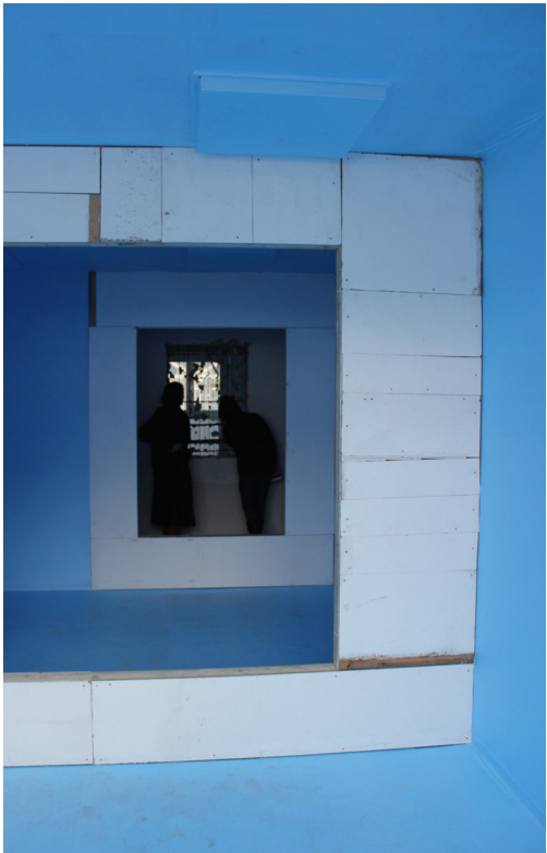
Der Durchbruch ist im Format A0 in die Wand gestemmt. Die Konstruktion der Wand wird offengelegt.
